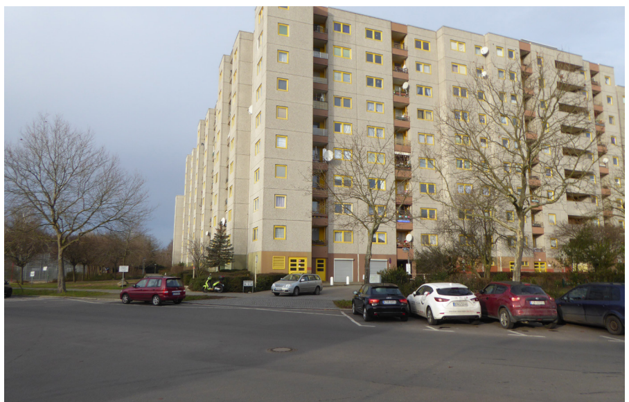
Massenquartiere im Hochhaus
